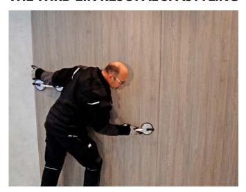
RESOPAL SpaStyling Boards lassen sich mit handelsüblichen Werkzeugen direkt vor Ort wie ein üblicher Holzwerkstoff be- und verarbeiten. Das RESOPAL SpaStyling Board kann bei Neubau- und Renovierungsobjekten direkt auf vorhandene Fliesen oder andere Untergründe geklebt werden. Die schnelle, einfache und saubere Montage sorgt für wenig Schmutz und geringe Ausfallzeiten der Räume.
