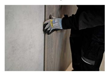
Das RESOPAL SpaStyling Board ist mit 7,8 mm Dicke eine leichte, ideale Lösung für Neu- und Umbauten von Nassräumen. Die Montage kann vor Ort mit minimalen Ausfallszeiten unter sehr sauberen Bedingungen erfolgen.
